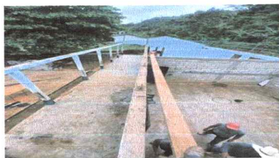
Foto 6: colocacion de andamio par la colocacion de block solera de cuatro hileras.
