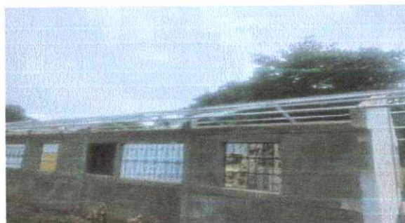
Foto 2: colocacion de estructura metalica
