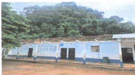
Foto 1: vista de la COPB Cuando su estructura era de madera
