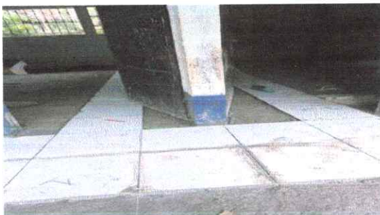
Foto 3: inicio de la colocacion del piso ceramico despues del levantado en su totalidad del entortado de cemento
